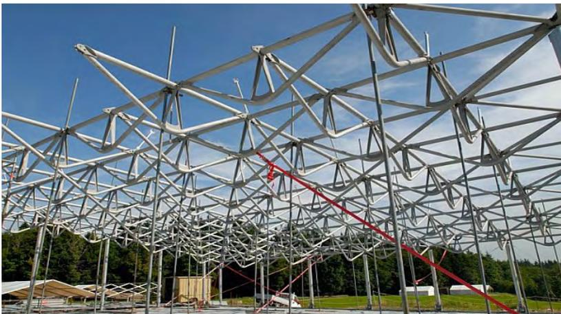
La structure s'adapte aux exigences du chantier archéologique. Si les découvertes nécessitent un agrandissement de la couverture, elle peut s'étendre par module de 300 m<sup>2</sup> sur toute sa périphérie. Les poteaux porteurs périphériques peuvent absorber le dévers de terrain naturel (1 m50 sur 30 m), et s'adapter aux vestiges situés de -2,5 m à -4 m.
